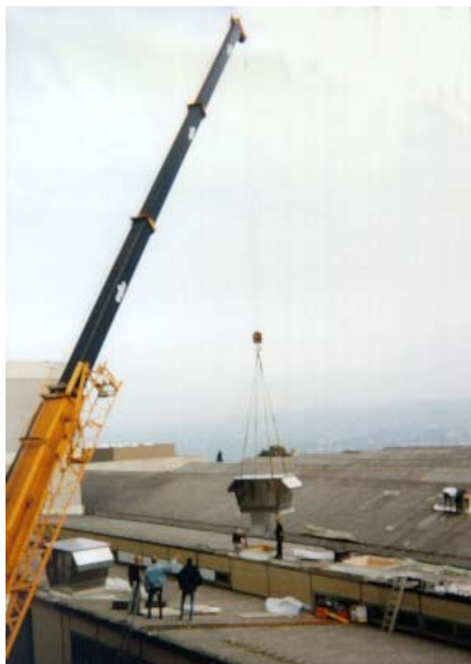
Монтаж с помощью крана
