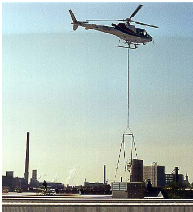
Монтаж с помощью вертолета
